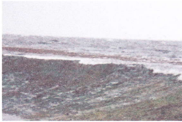
Sturmflut im Oktober 2007: Das Wasser steht dicht unter der Oberkante des Sommerdeichs. Wäre dieser Deich jetzt offen, wie es in der Ausgleichsmaßnahme vorgesehen ist, würde mit dem Wasser auch jede Menge Treibsel in den Langwarder Groden gelangen.
